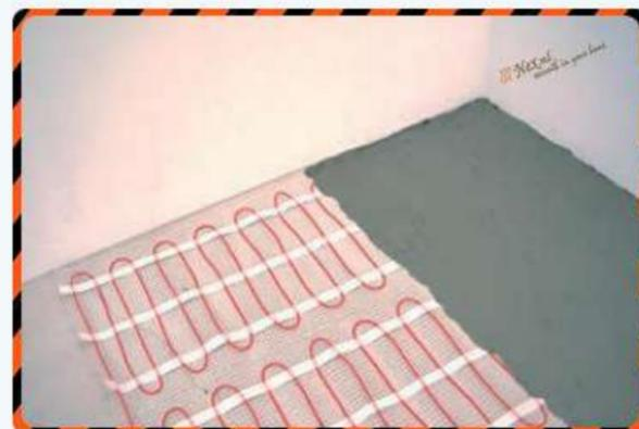
Не допустимо сближение петель нагревательного кабеля на расстояние менее 70 мм. Радиус изгиба кабеля должен быть не менее 37,5 мм.
